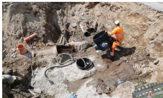
VA-omläggning på Aron Nils väg
