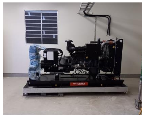
Lärkan & Bränneriet; Brandskyddsåtgärder och målning av lokal är klar inför installation av reservkraft för Broby Lärkan VV och pumpstation Bränneriet. Till Bränneriets pumpstation kommer allt avloppsvatten från Glimåkra, via Knorrevången pumpstation, som sedan pumpas vidare till Broby reningsverk.
