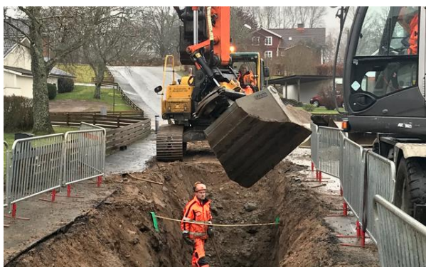
Omläggning av VA-ledningar, Otto Holm området, Osby kommun
