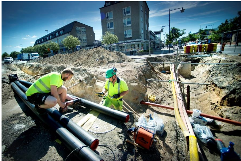
VA-arbete, Storgatan i Bromölla.
