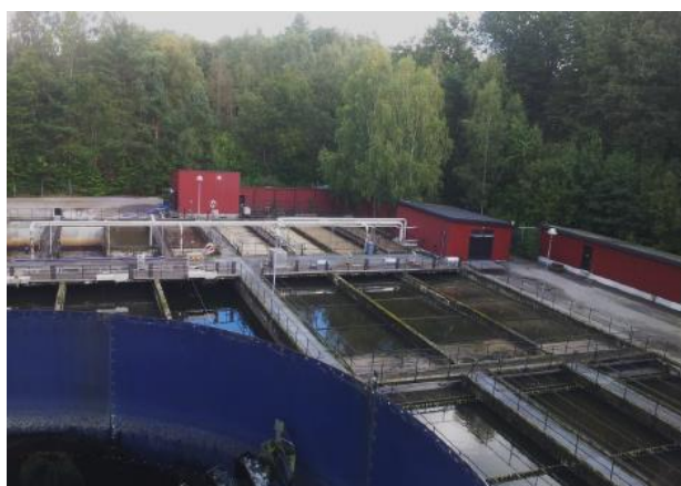
Reningsverket i Jämshög.
