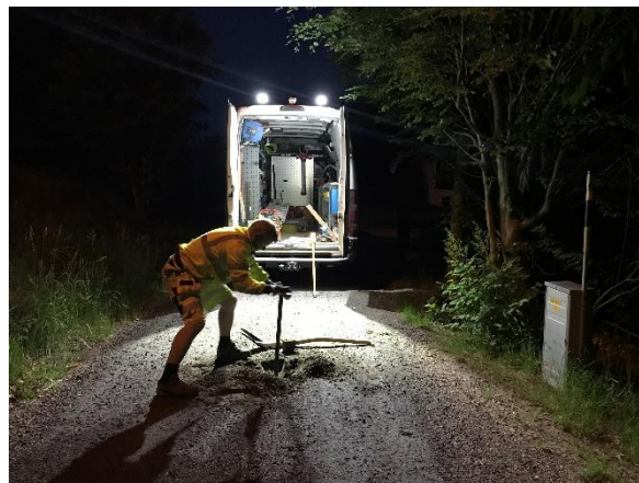
Mattias Gustavsson, SBVT, söker efter en vattenläcka i Killeberg.
