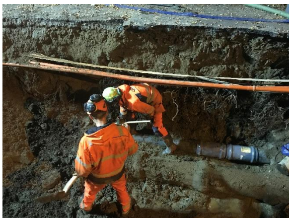
VA-arbete, Norra Infartsvägen i Osby
