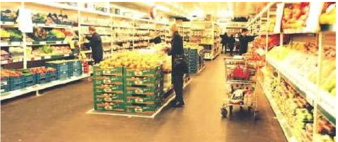
Noslēgta atsevišķi dzesējama veikala telpa no pārējās veikala daļas (bieza siltumizolācija)
