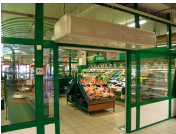
Noslēgta atsevišķi dzesējama veikala telpa no pārējās veikala daļas (dubultais stiklojums)
