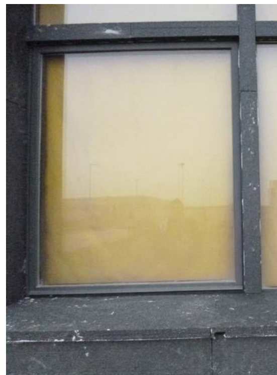
revêtement thermique - étape 1
