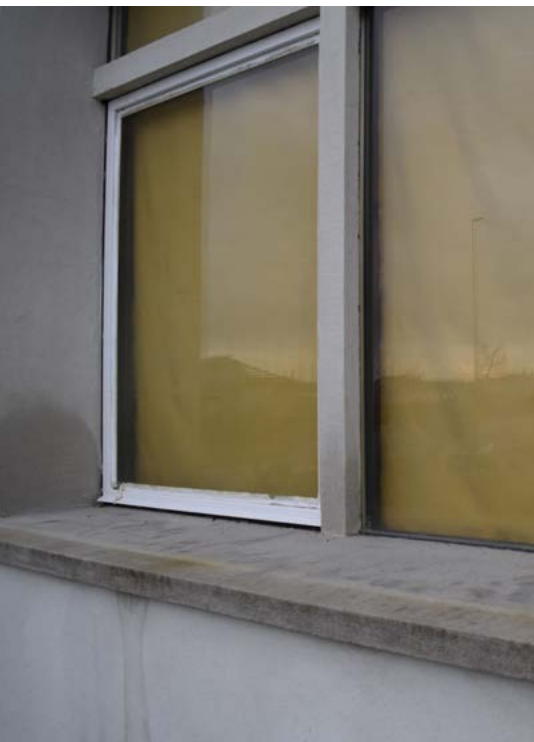
revêtement thermique - étape 2
