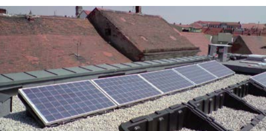
système photovoltaïque sur un toit plat
