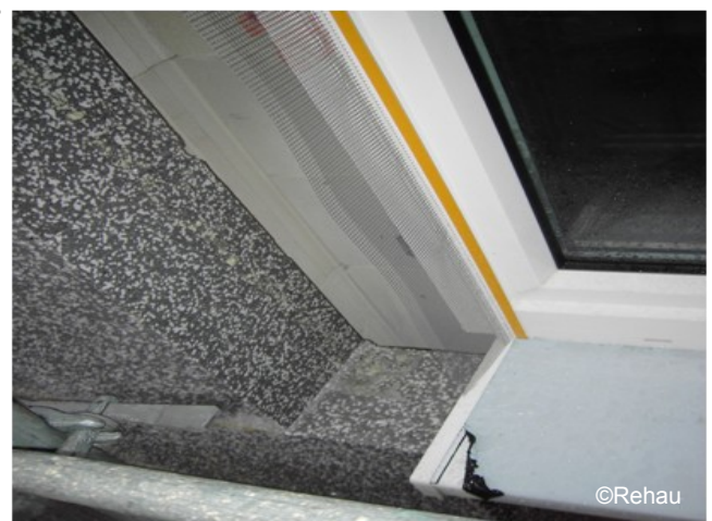
Luftdichter und wärmebrückenfreier Fensteranschluss
