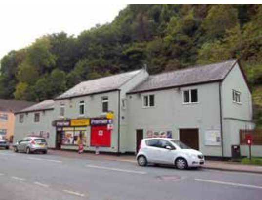
Εξωτερική όψη του "Central Stores"
