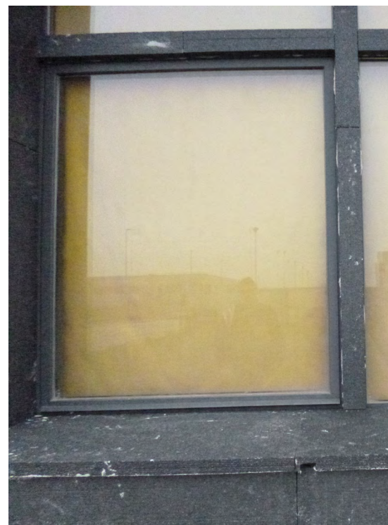
Rivestimento termico delle finestre – prima fase
