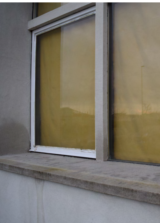
Rivestimento termico delle finestre – effetto finale
