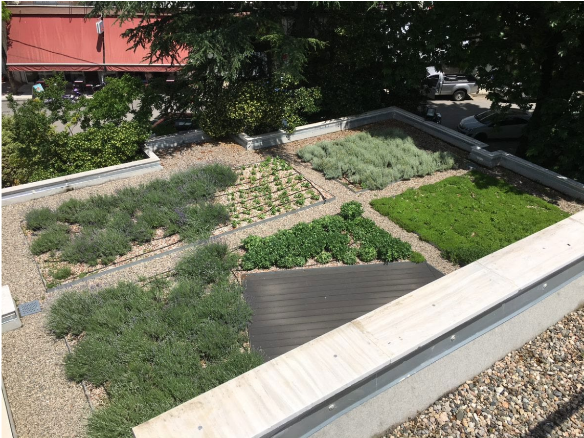
Grön takterrass vid stadshuset i Edessa, Grekland Foto: Energikontor Sydost
