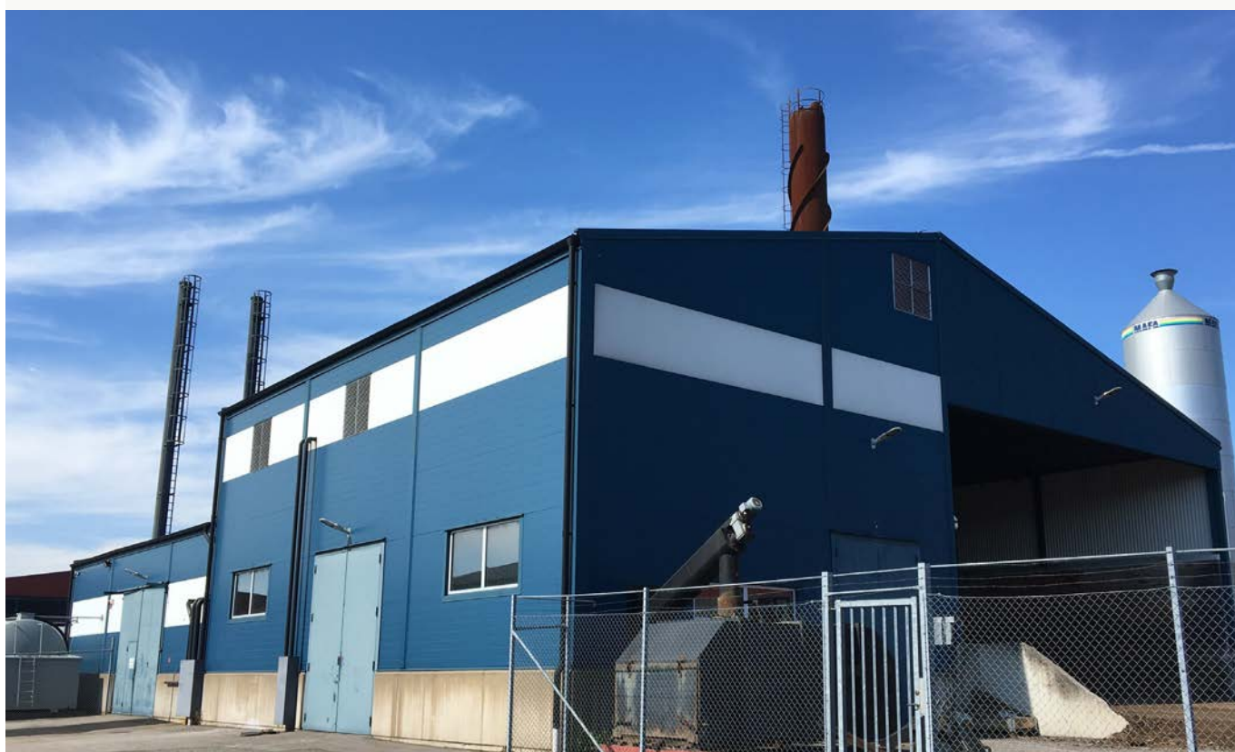
Fjärrvärmecentralen i Bräkne-Hoby använder småskalig kraftvärmeteknik för att producera el. Foto: Johanna Wallin
