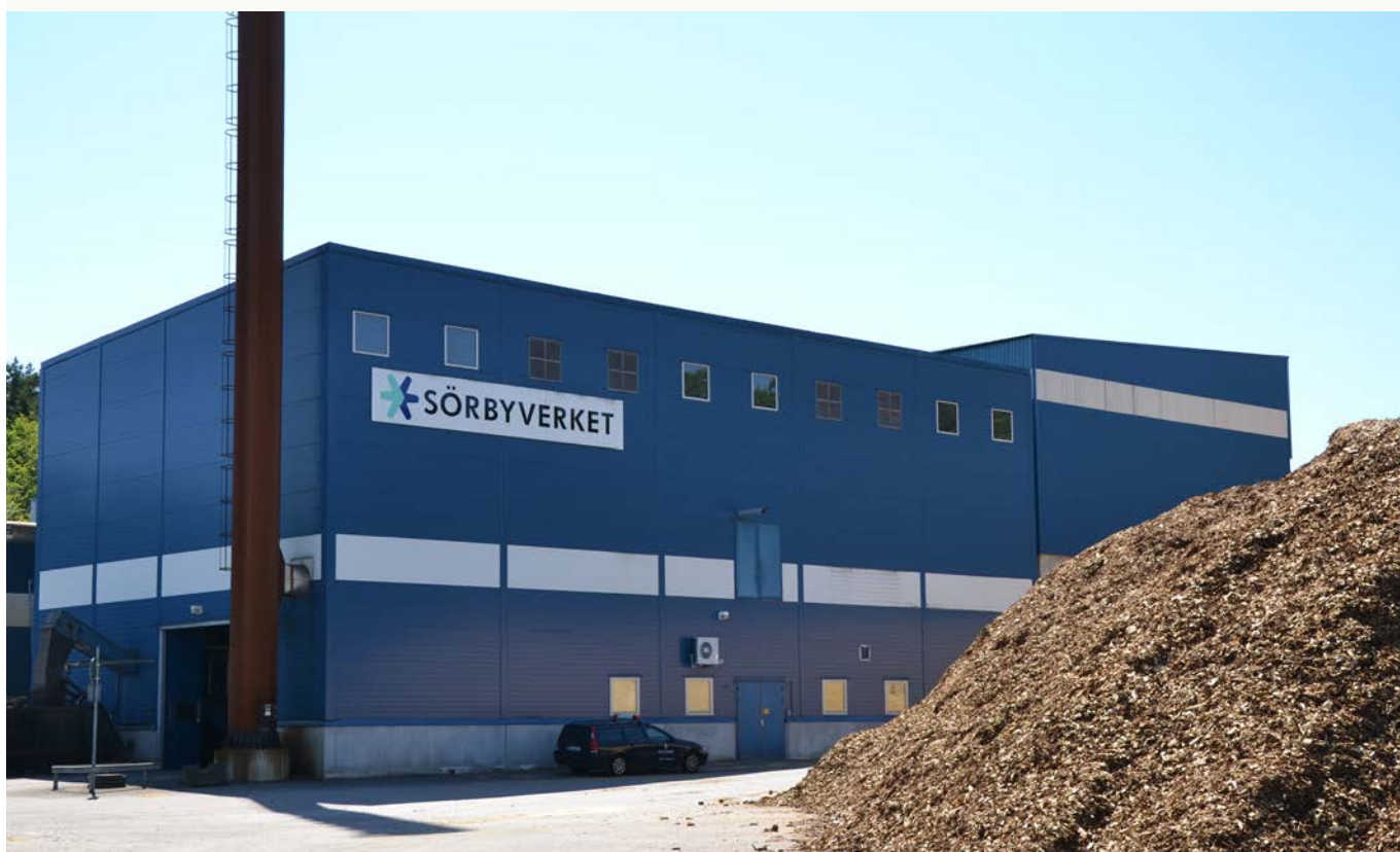
Fjärrvärmecentralen Sörbyverket i Ronneby. Foto: Johanna Wallin
