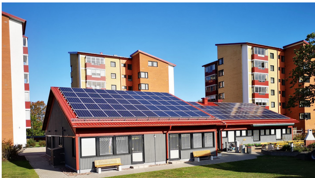
Bild 1. Solceller på BRF Jätten i Kalmar. Foto: BRF Jätten
