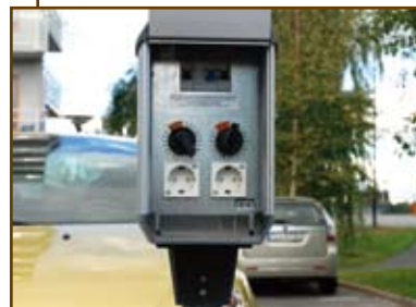
Äldre motor- värmaruttag
