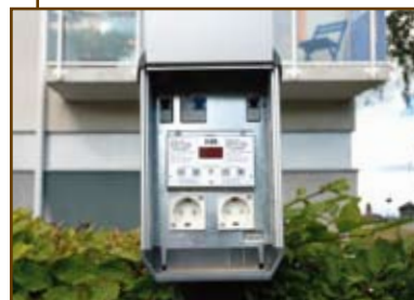
Äldre motor- värmaruttag
