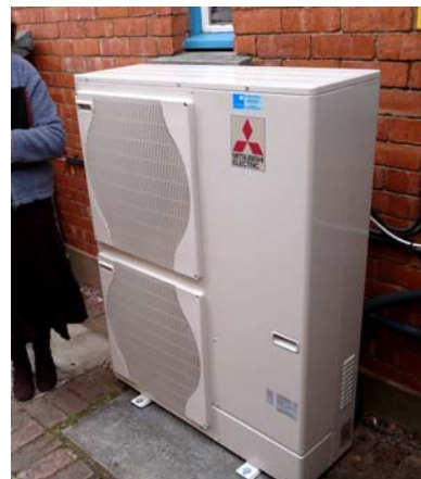
Luftvärmepumpens utomhusdel
