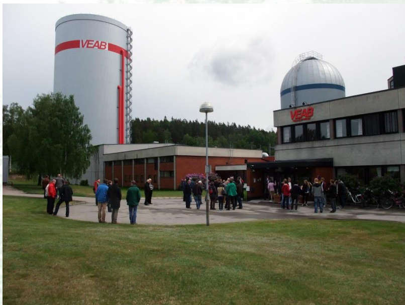
Figure 27 - Sandvik CHP plant, Växjö
