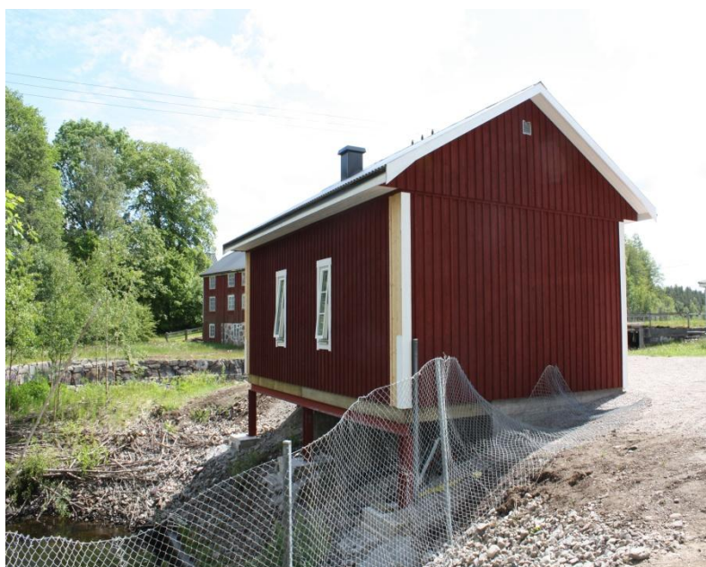
Figur 2. Nuvarande anläggning under uppförande, Barsbro kraftaktiebolag
