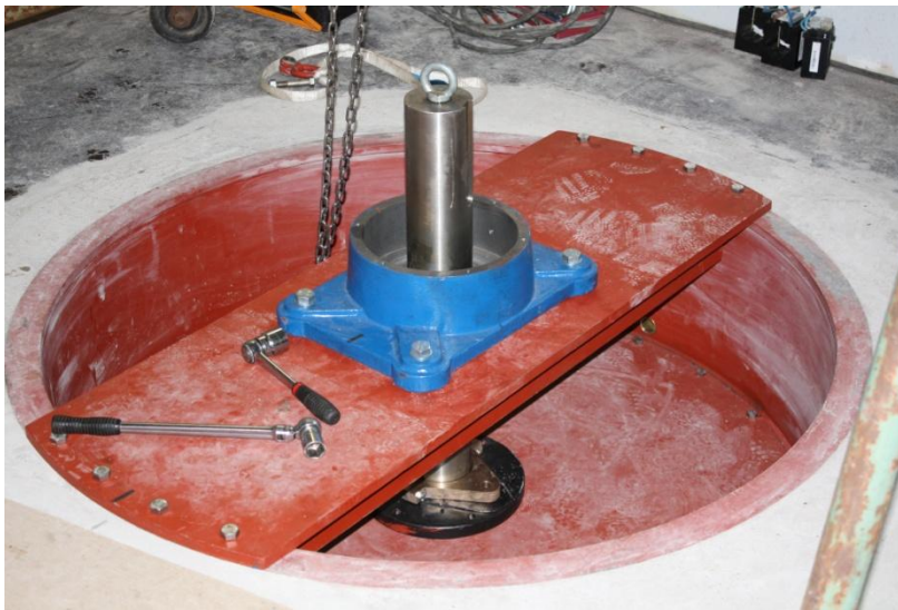
Figur 3. Infattning av turbinaxel i lager, Barsbro kraftaktiebolag
