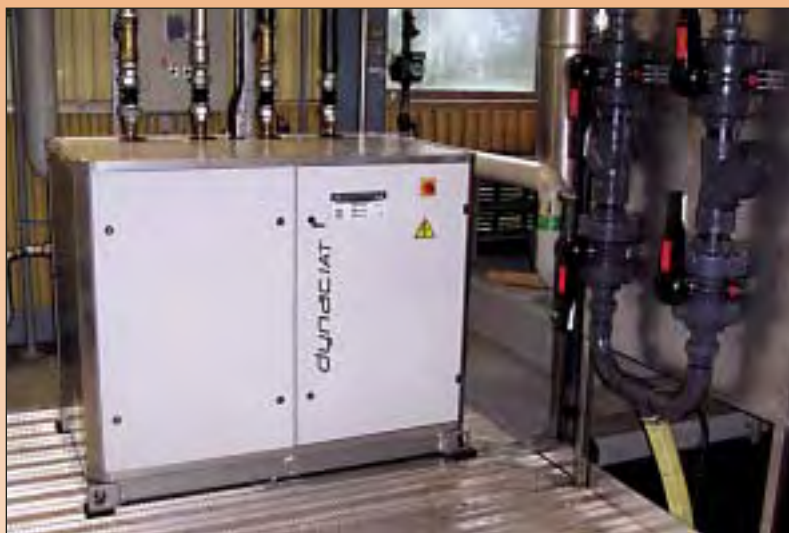
En ny värmepump på Moheda Reningsverk har ersatt den gamla oljepannan.
