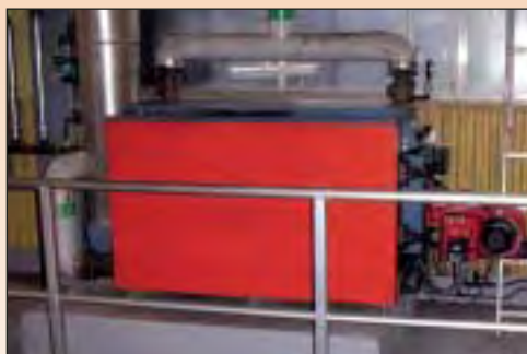
En ny värmepump på Moheda Reningsverk har ersatt den gamla oljepannan.
