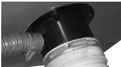
Bild 19: Montering av sugslangarna
