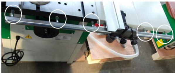
Bild 8: Montering av stoppstyrskenan
