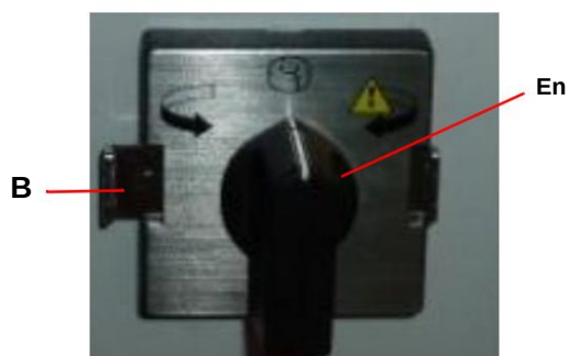
Bild 21: Riktningarbrytare
