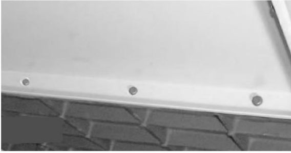
Bild 11: Montering av stålförlängningsbordet
