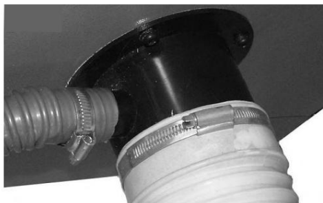
Bild 27: Montering av sugslangarna
