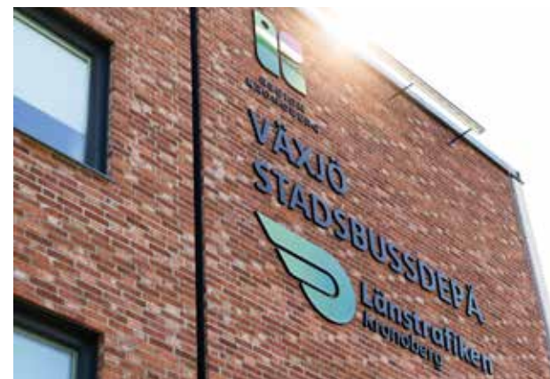
Återbrukat tegel på fasaden av elbussdepån.
