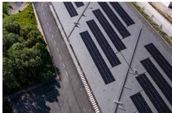
Solceller på taket ovanför stadsbussarna.
